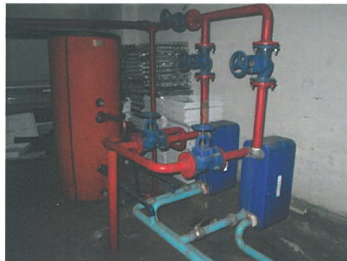
Топлообменни апарати и буферен съд за БГВ
