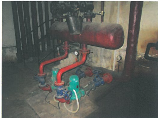
Разпределителен колектор и циркуляционни помпи за БГВ
