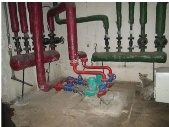
Разпределителен колектор и циркуляционни помпи за вентилационни камери
